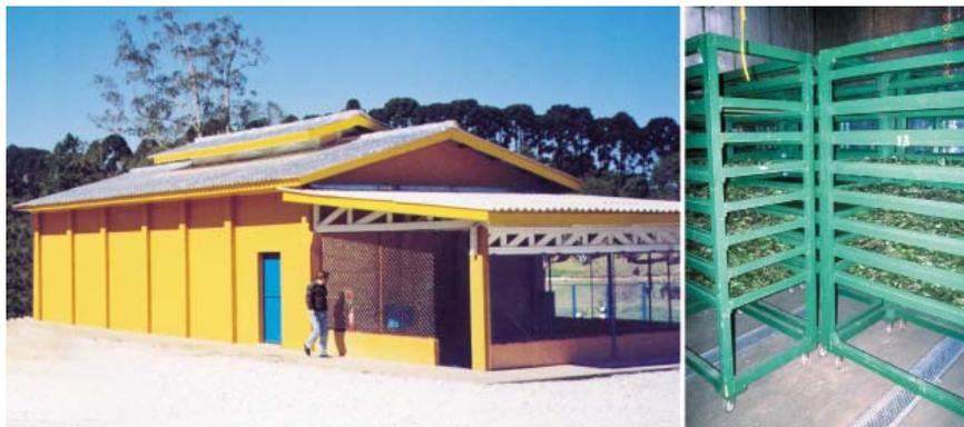
*Figura 15 – Secador tipo lanternim. No detalhe, porta-bandejas com rodízios para facilitar as operações de preparo e secagem.*
